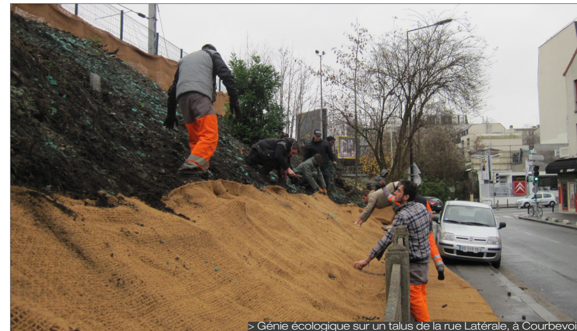
> Génie écologique sur un talus de la rue Latérale, à Courbevoie
