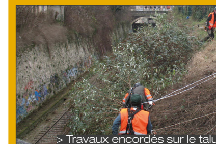
> Travaux encordés sur le talus
