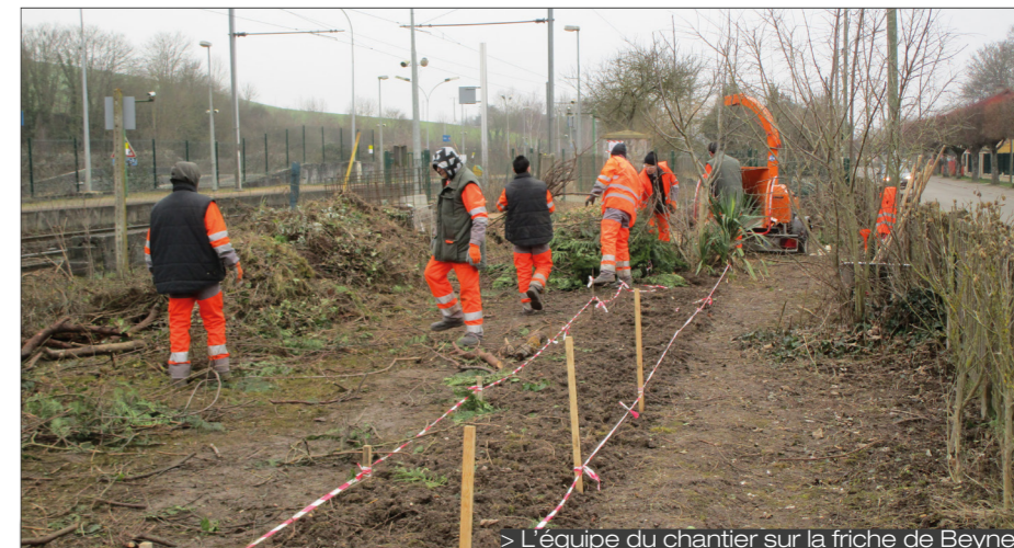
> L'équipe du chantier sur la friche de Beynes
