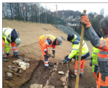
▼ Muret de soutènement
