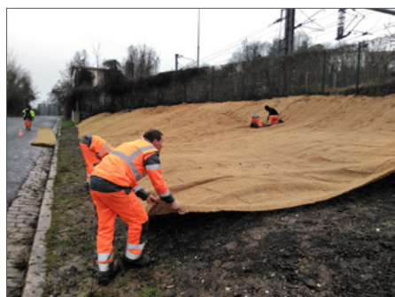
▼ Pose d'un géotextile avant plantation
