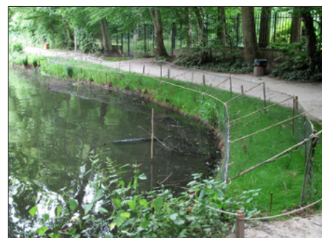
▼ Rive en pente douce (après travaux)
