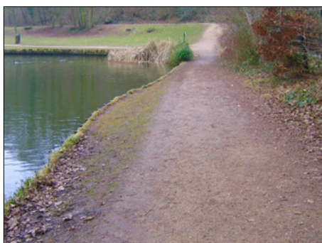
▼ Tunage en bordure d'étang (avant travaux)
