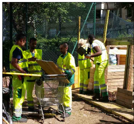
▼ Le chantier du compostage de Paris 16 e
