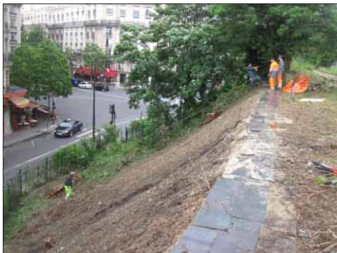
Salarié encordé sur le talus de Balard dans le 15 e arrondissement de Paris
