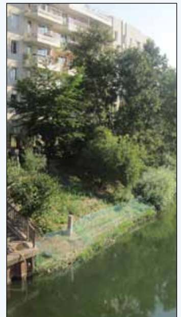
Ouvrage de génie végétal réalisé à Issy-les-Moulineaux
