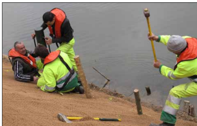
Création d'un ouvrage de génie végétal à Issy-les-Moulineaux
