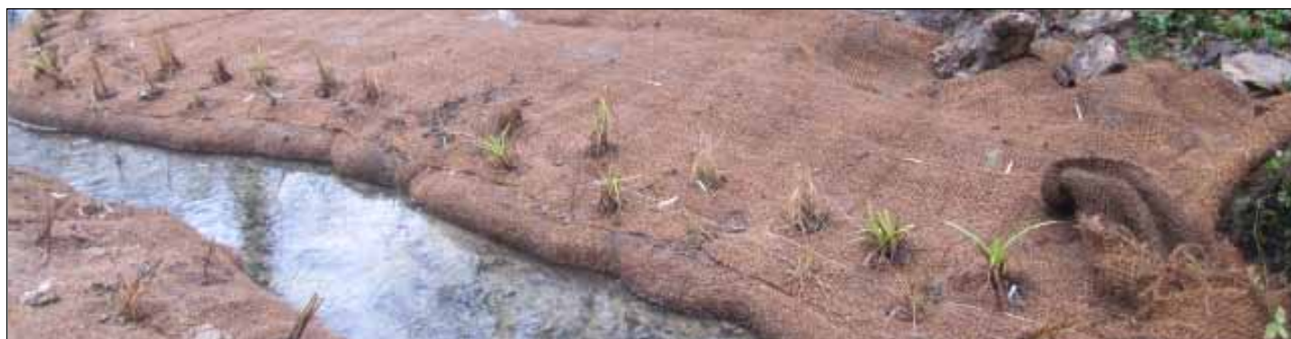
Ouvrage de restauration des berges du ru de Vauresson au Domaine national de Saint-Cloud
