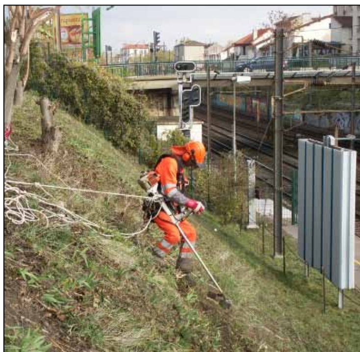
Intervention encordée sur un talus en gare de La Garenne-Colombes
