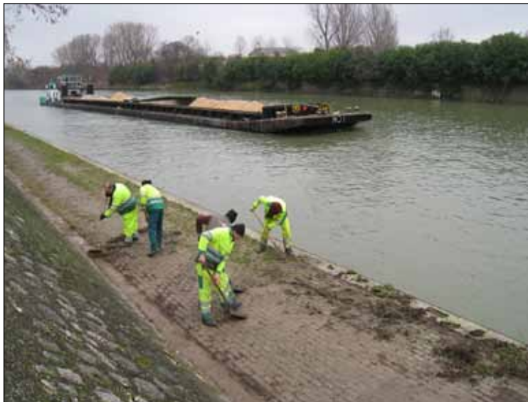
Remise en état des pavés du quai de Dion Bouton, à Puteaux.
