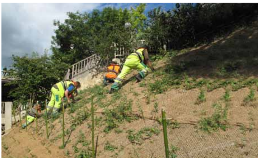
Entretien de l'ouvrage de génie végétal de l'île Saint-Germain à Issy-les-Moulineaux.
