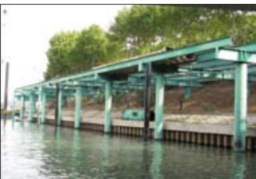
La base-vie en cours de démontage.
