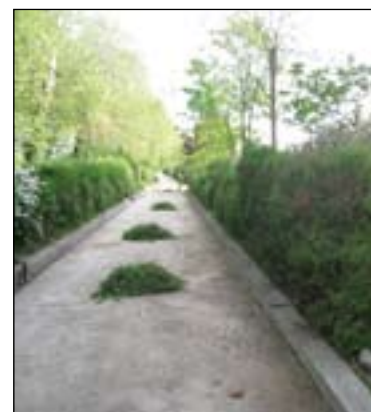
Entretien des berges de Seine à Saint-Cloud en 2010.
