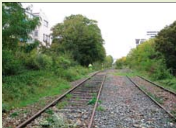
Le chantier d'insertion de la Petite ceinture 15 e -14 e à Paris.
