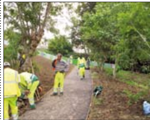
Le chantier du Jardin botanique à Issy-les-Moulineaux.
