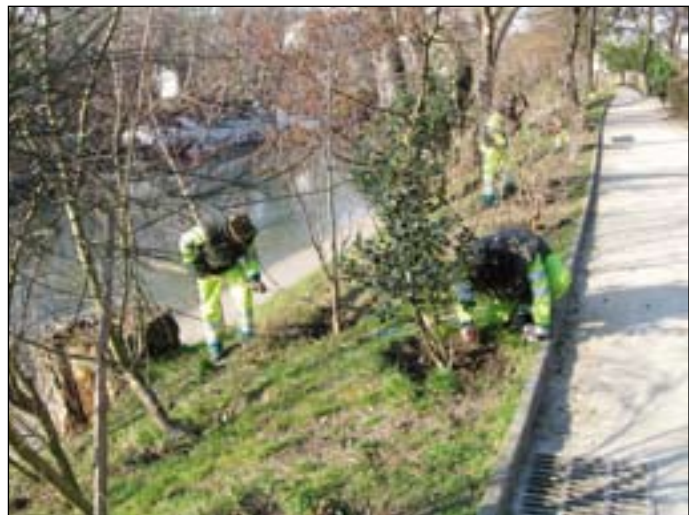
Le chantier des berges de Seine à Issy-les-Moulineaux.
