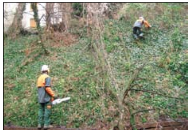
Chantier d'abattage sur la Petite ceinture 15 e /14 e à Paris.
