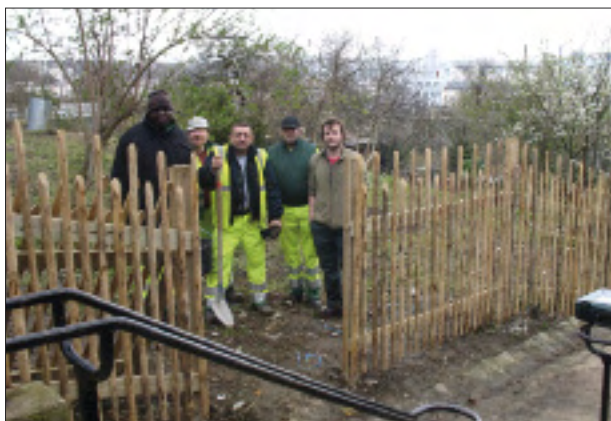
Les travaux de pose de la barrière et l'équipe à la fin de l'ouvrage.
