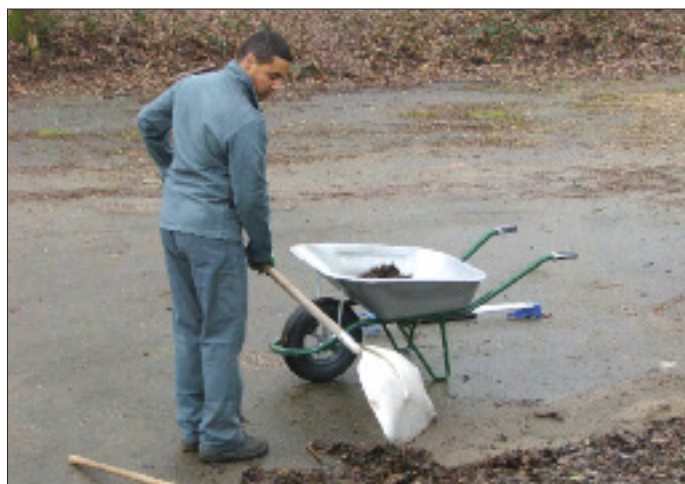
Nettoyage des caniveaux permettant le ruissellement des eaux.
