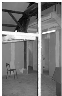
Les travaux des locaux du Pavillon du combat
