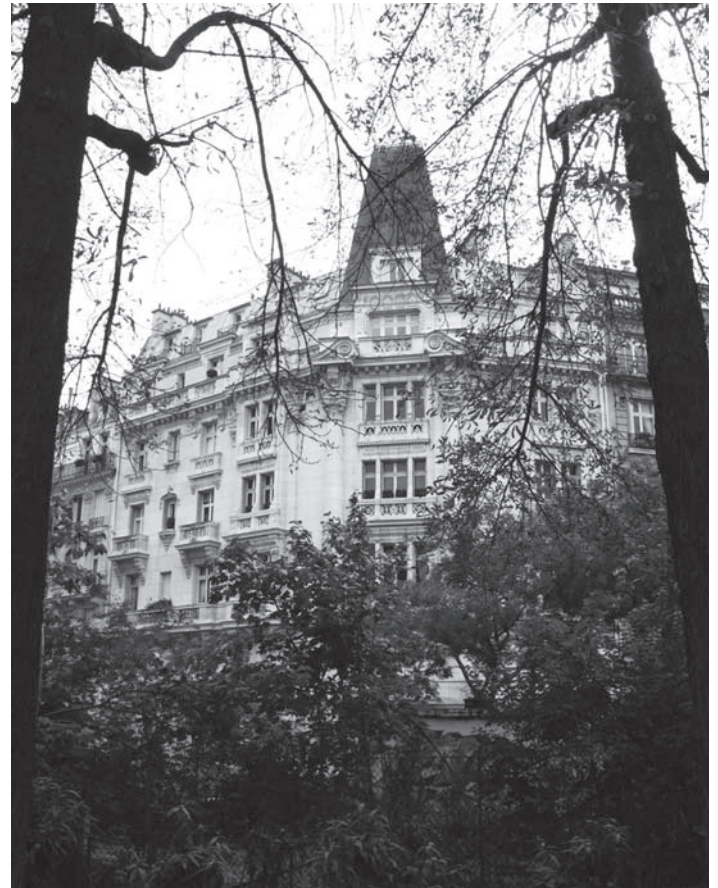
Vue d'un immeuble depuis la Petite ceinture 16 e
