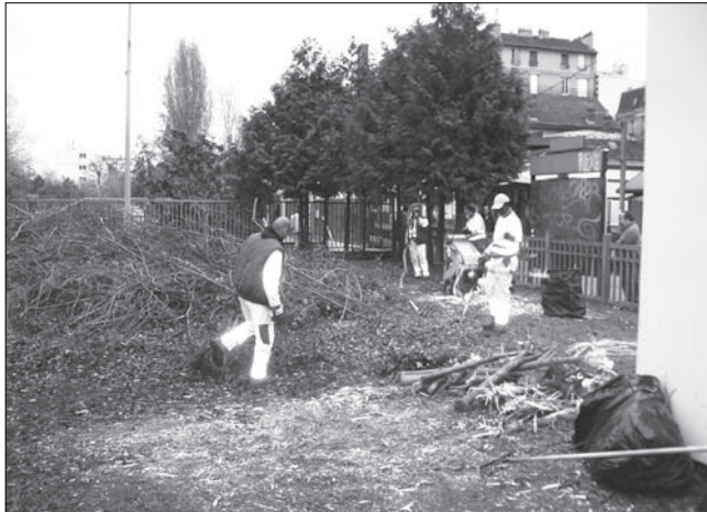
Opération de broyage de feuilles sur le chantier Talus ferroviaires aval à la gare des Vallées (Colombes)
