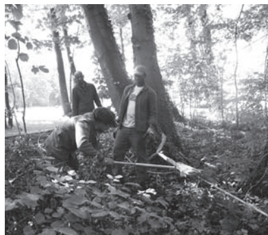
Maniement du tirfor pour tirer l'arbre de l'eau
