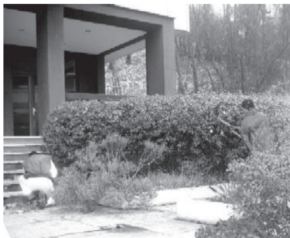
Le travail à la copropriété de Sèvres a été réalisé par l'équipe Chantier d'Espaces
