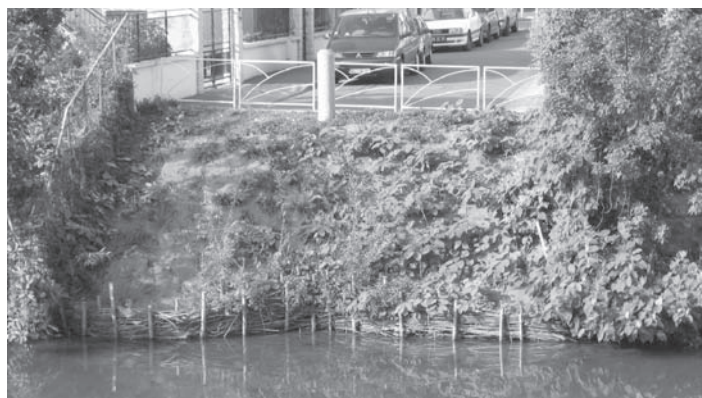
Cet ouvrage en génie végétal à Issy-les-Moulineaux pour maintenir les berges de l'île Saint-Germain a été réalisé par l'équipe chantier en février 2005 ; la photo, prise en octobre 2005, illustre la réussite du projet : les plantes se développent et le maintien du talus est assuré.
