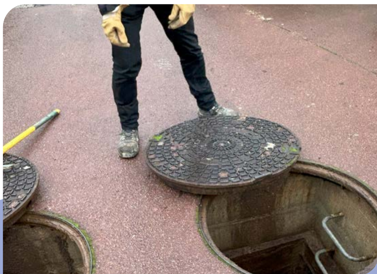
Investigations avec Veolia et la Ville de Rueil-Malmaison afin de retrouver les eaux de source rejetées dans le réseau d'assainissement
