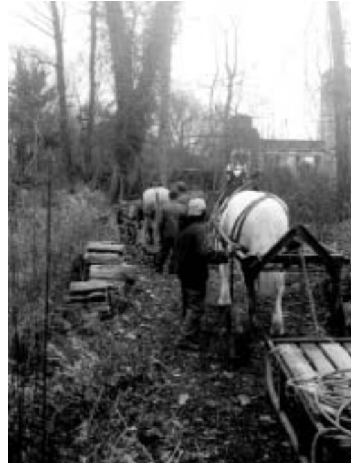
L'équipe du chantier d'insertion du Domaine national de Saint-Cloud utilise exclusivement l'énergie chevaline pour le gros-œuvre.
